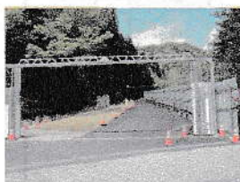
間沢（くらがりさわ）川右岸側 工事用道路整備（済）
