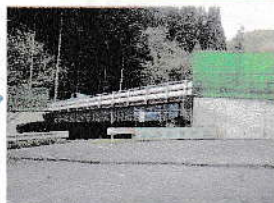
間沢（くらがりさわ）川 工事用仮橋設置（済）
