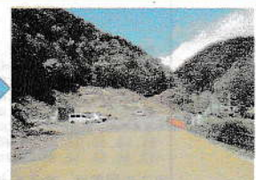
施工ヤード 造成予定地
