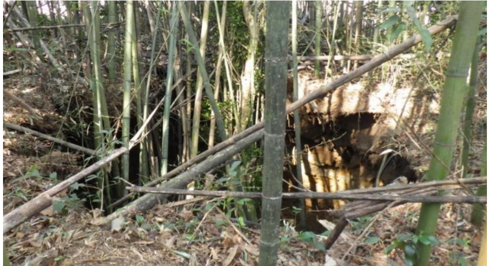
トンネル工事により土砂が崩落した竹林、鉄道・運輸機構提供
