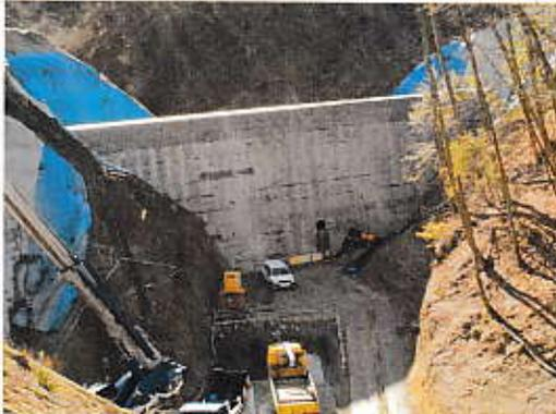
写真⑤ 搬入道路下部土留擁壁 構築完了状況
