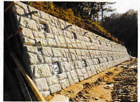
写真④ 盛土下部土留擁壁 構築完了状況
