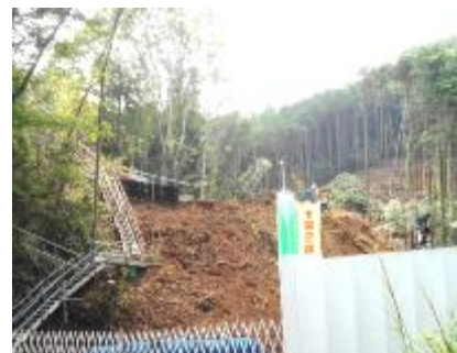
長竹非常口工事現場
