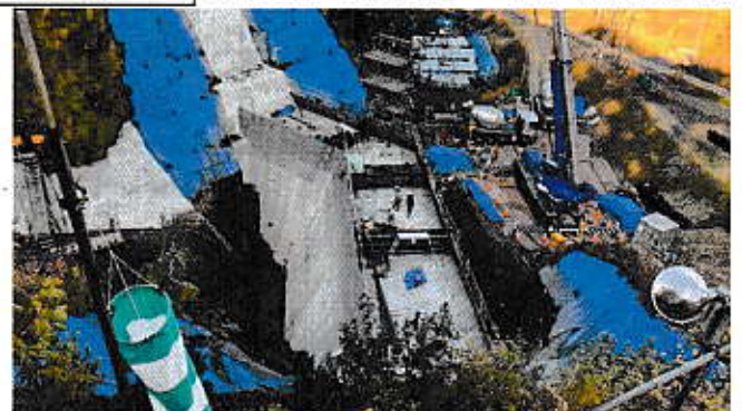
写真①-2 沈砂調整池堰堤 コンクリート打設状況
