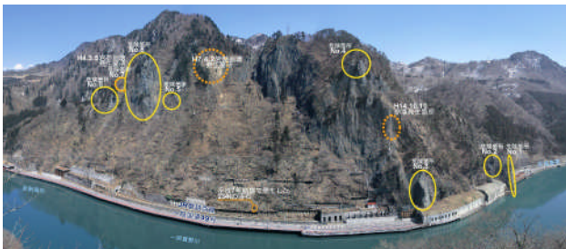
岩石崩落危険箇所
