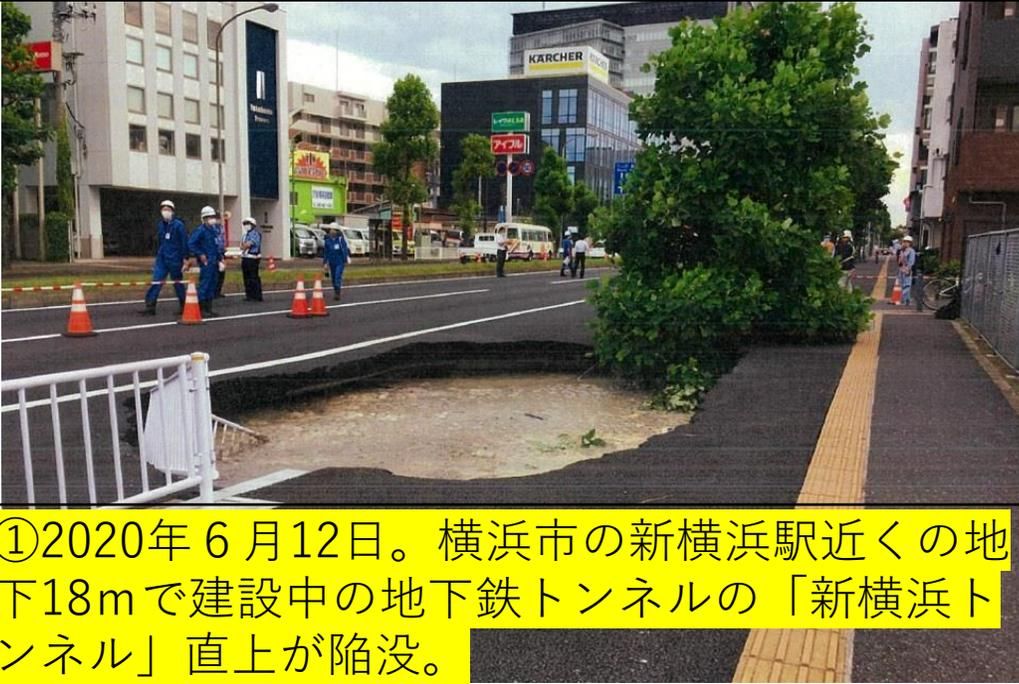
①2020年6月12日。横浜市の新横浜駅近くの地下18mで建設中の地下鉄トンネルの「新横浜トンネル」直上が陥没。
