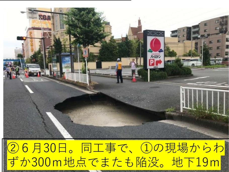
②6月30日。同工事で、①の現場からわずか300m地点でまたも陥没。地下19m
