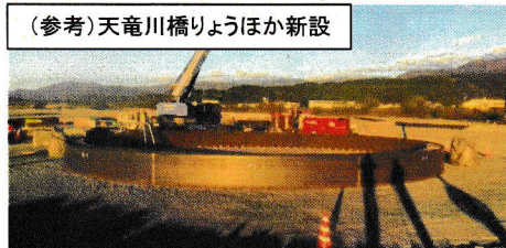
①作業室構築
