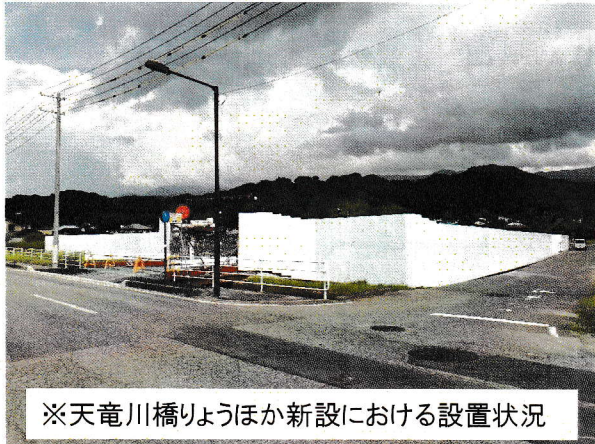
仮囲いの設置
