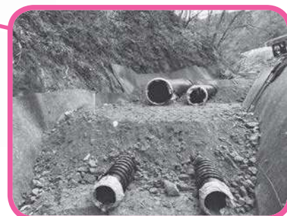
地下排水管設置
