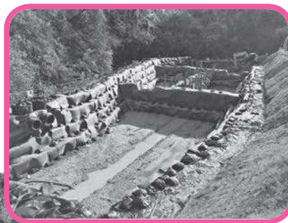
仮設沈砂池設置
