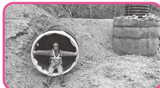
盛土施工中の火沢川を切り替えるために使用している地下排水管は内径1.35mの高耐圧ポリエチレン管です。
